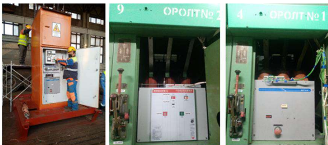
Экс №38-ийн ЯКНО-г вакум таслуур, микропроцессорын VAMP релейгэертонголож, ХХБ№1-Орол№20-Яч№9, ХХБ№1-Орол№1-Яч№4-ийн тосон таслууруудыг Вакум таслуураар сольсон байдал
