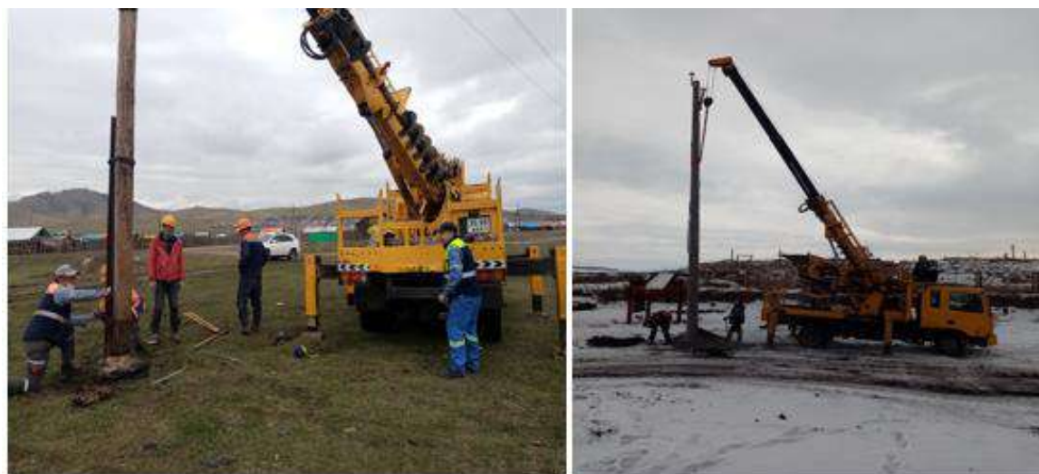
ЦДАШ №12-ыг сэргээн засварлаж мод солих, зарим тулгуурыг төмөр бетон тулгуураар сольж байгаа байдал
