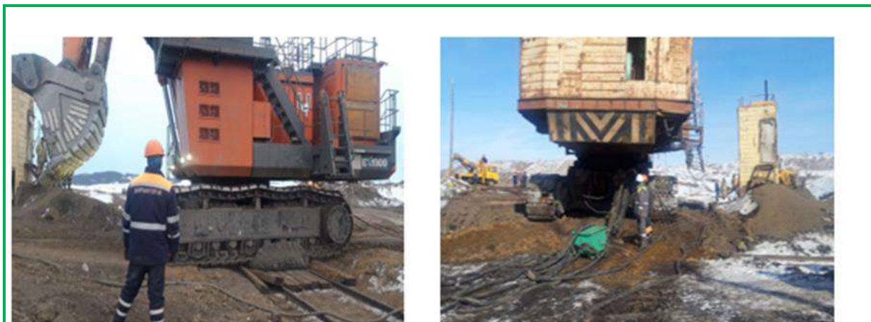
Экс №51, Экс №38-ийг Шаазгайтын орд руу нүүлгэж байрлуулах, мөн буцаан нүүлгэж үндсэн мөргөцөг рүү оруулахаар шинээр ЦДАШ барих, шилжүүлэх ажлууд
